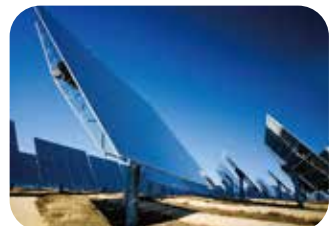
太陽光発電モジュール
