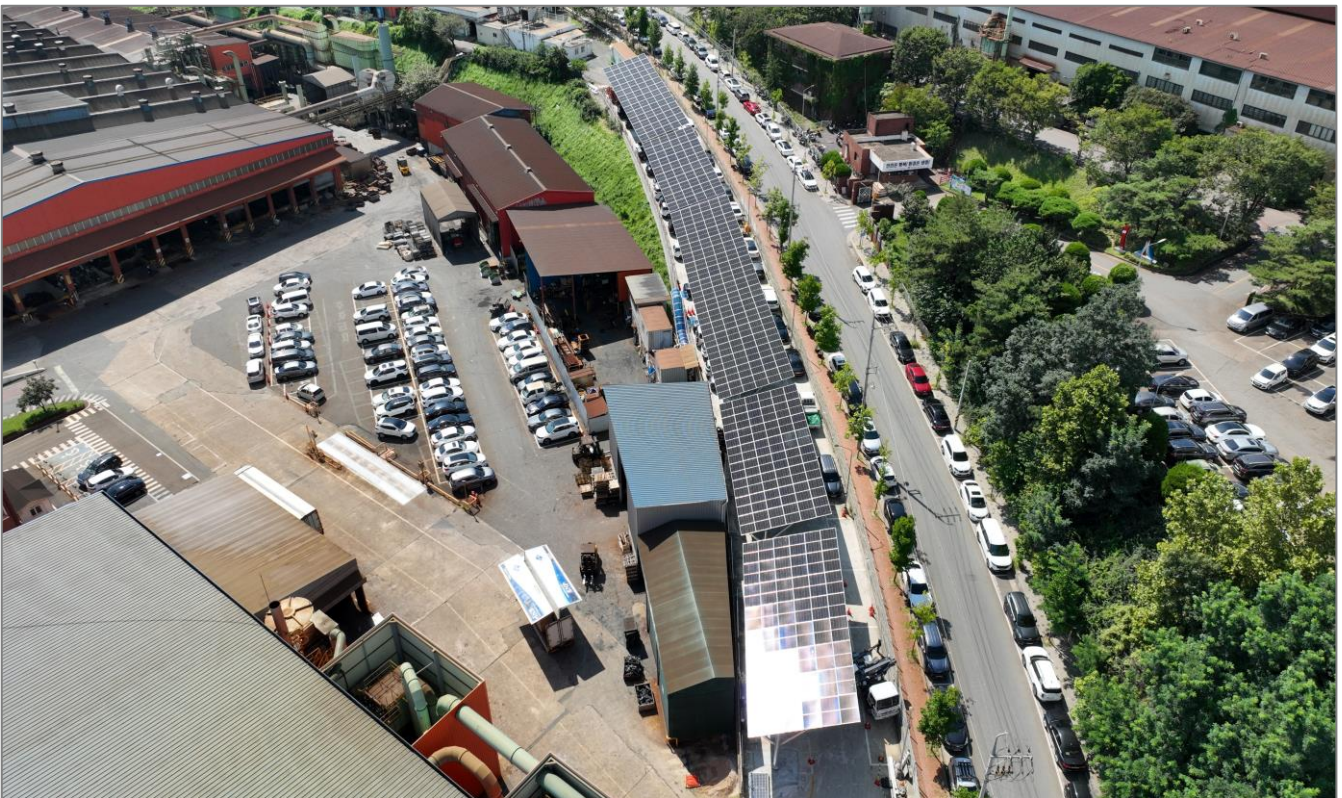
달성 태양광발전소 설치용량 : 200kW
