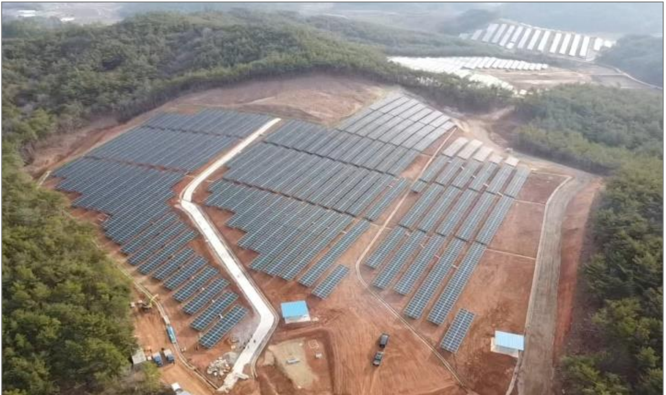
신안 태양광발전소 설치용량 : 5,000kW
