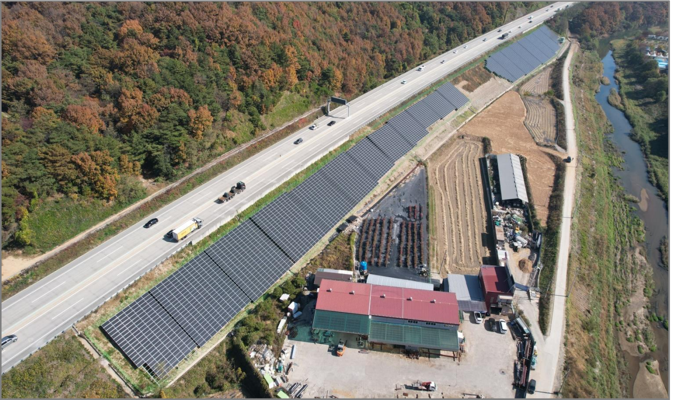
봉안리 태양광발전소 설치용량 : 2,000kW
